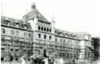
Sanatoriet under opførelse. Besigtiges af bestyrelsen?
