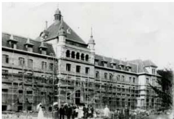
Sanatoriet under opførelse 1899
